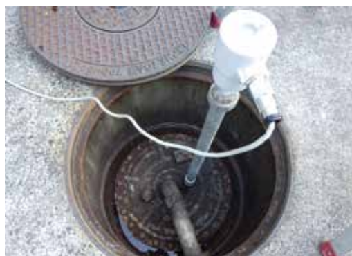
磁歪式液面変位センサー
