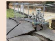
水道の復旧 (被災した浄水場)
